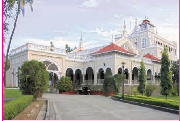
आगा खाँ पैलेस, पुणे
